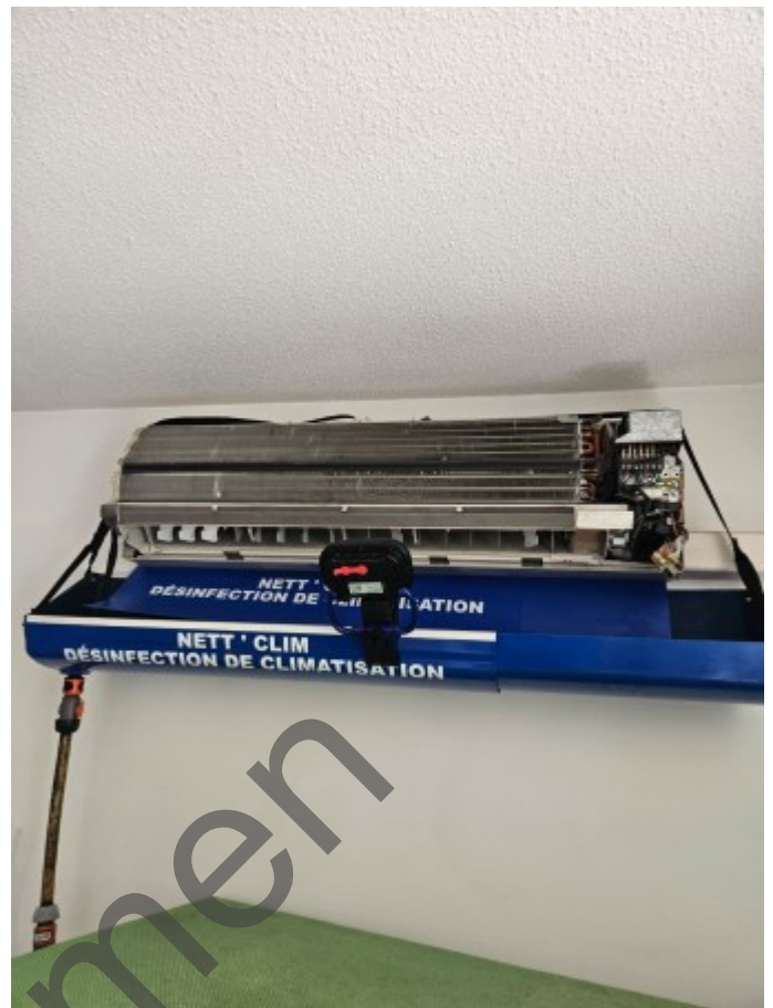
Mise en place protection
